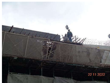
ภาพที่ 2.2-55 การติดตั้ง Mesh Sheet และ Chain Link
