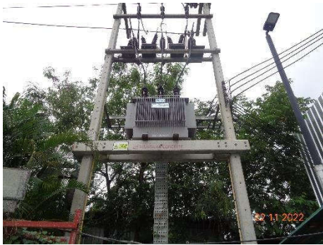
ภาพที่ 2.2-44 หม้อแปลงไฟฟ้าของโครงการและแผงควบคุม/ตัดกระแสไฟฟ้า
