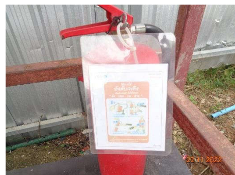
ภาพที่ 2.2-20 ถังดับเพลิงมือถือและป้ายแสดงวิธีการใช้งาน
