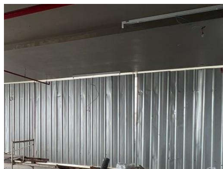
ภาพที่ 2.2-56 การติดตั้งแผ่นกันเสียงแบบเคลื่อนย้าย (Metal Sheet)
